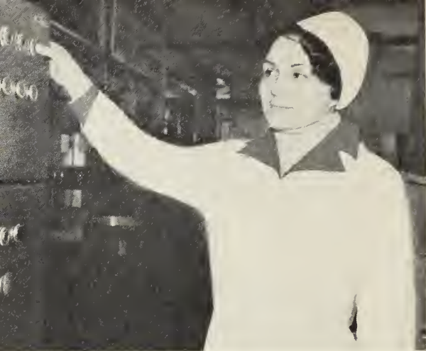
El tablero de la instalación criógena.
